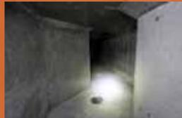
主棟1階床面を取り囲む煙道は、地震や大雪などで倒壊した建物内部に取り残された人の救出訓練も行えます。狭く閉鎖された空間は、訓練に緊張感をもたらします。煙道上部にグレーチングを設け、側溝内に見立てた訓練もできます。
