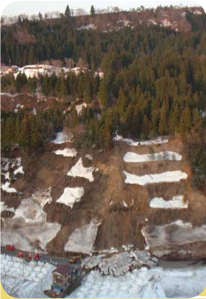
平成 18 年 4 月 10 日 町市田麦地内「がけ崩れ」
